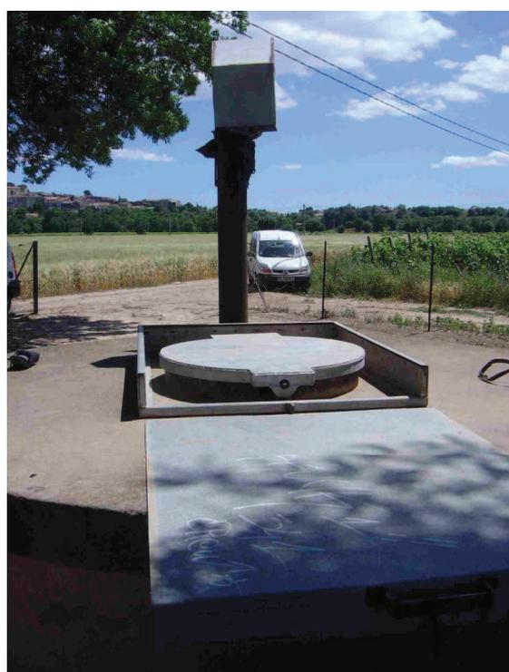
**Détail du dispositif de fermeture du puits**
