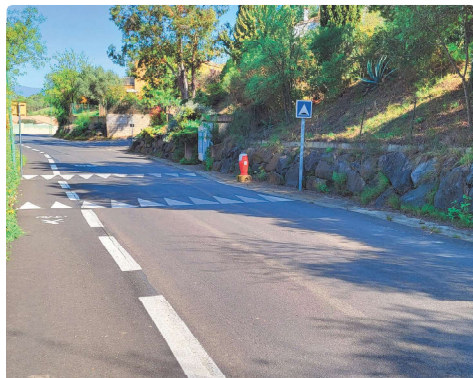
Création d'une voie douce chemin du l'Aventin
