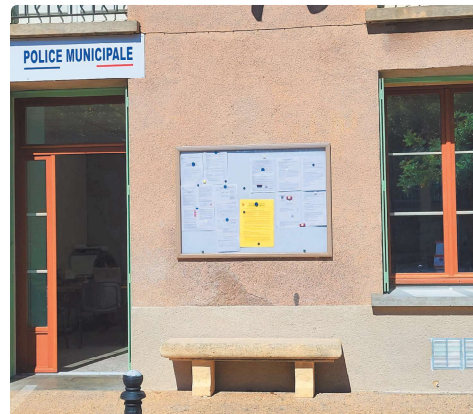
Création bureaux de la Mairie
