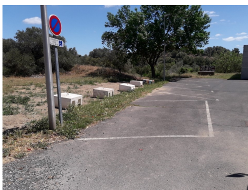
Pose d'une buse près de la salle polyvalente
