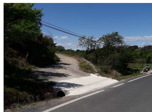
Réparation du pontil avec changement de buse Route de Pomerols
