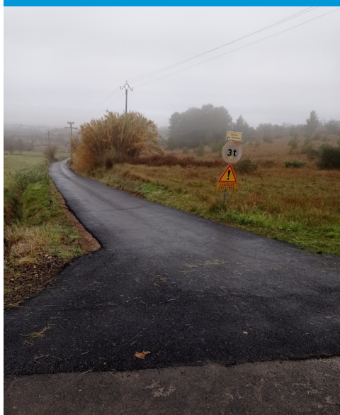
Réfection de la première partie du chemin des Saliniers
