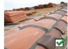
Les rives constituent l'extrémité du toit côté pignon. Elles seront réalisées par une double rangée de tuiles de couvert chaînées et scellées au mortier de chaux. Elles seront sans débord et sans tuiles à rabat.
