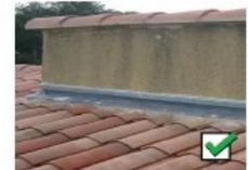
Les solins seront exécutés en plomb pour une bonne adaptation aux tuiles canal avec une bande porte solin recouverte par l'arrêt de l'enduit. Le zinc peut éventuellement être admis, bien que plus rigide.
