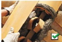
Les faitages avec des closoirs ventilés ne sont pas appropriés aux toits anciens. Ce montage à sec ne permet pas de maintenir les dispositions d'origine correspondant à l'époque de construction de l'immeuble.
