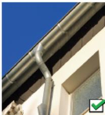
La réalisation des travaux doit permettre l'amélioration du parcours des canalisations d'évacuation des eaux pluviales et la rationalisation de leur nombre et de leur section. Elles seront apparentes en façade sans altérations des modénatures, judicieusement placées en limite de façade ou dans les angles.
