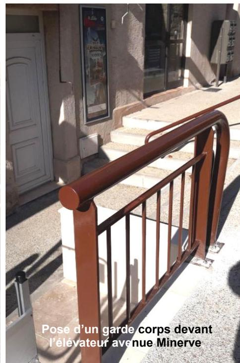
Pose d'un garde corps devant l'élévateur avenue Minerve
