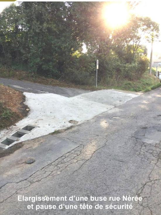
Elargissement d'une buse rue Nérée et pose d'une tête de sécurité
