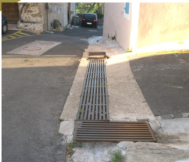
Poursuite de la réfection des grilles et rigoles d'évacuation des eaux pluviales dans le centre du village.
