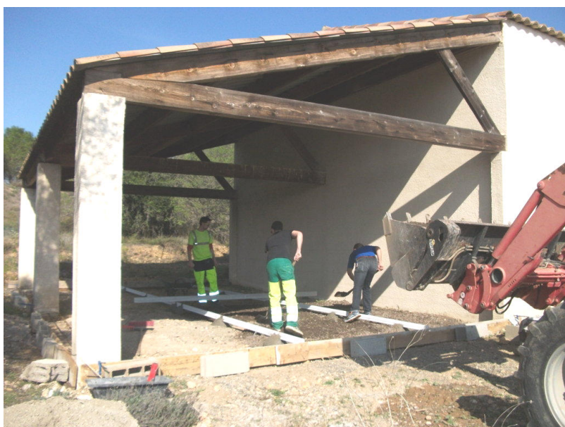
Travaux d'aménagement des futurs ateliers municipaux.
