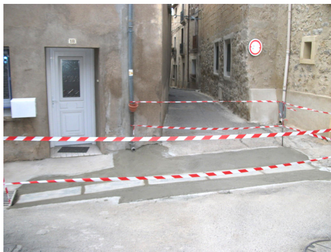
Poursuite de la réfection des grilles et rigoles d'évacuation des eaux pluviales dans le centre du village.
