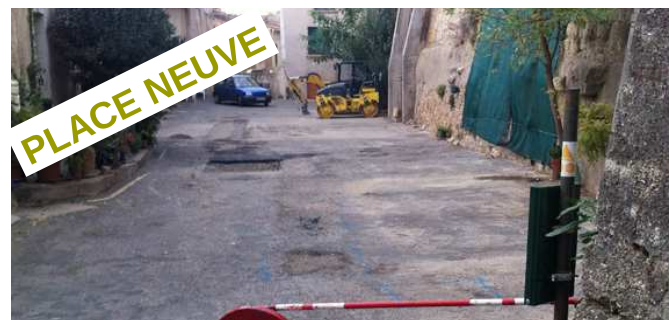
La rue Mégère après les travaux
