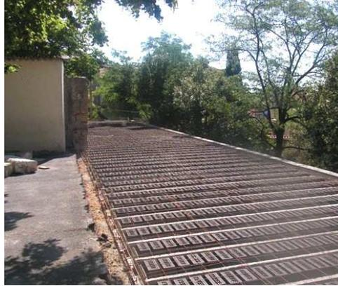
2—La structure métallique qui supportera le dallage en béton est posée.
