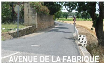
Suite à l'effondrement du bas côté de l'Avenue de la Fabrique au printemps dernier, des travaux ont été réalisés pour **élargir la chaussée et améliorer l'écoulement des eaux**. Cet effondrement était dû au ravinement important provoqué par les pluies abondantes.
